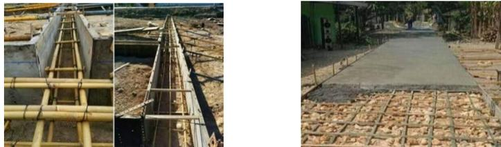
Gambar 3. Konstruksi Rumah Tinggal dan Jalan Rabat Menggunakan Bambu
